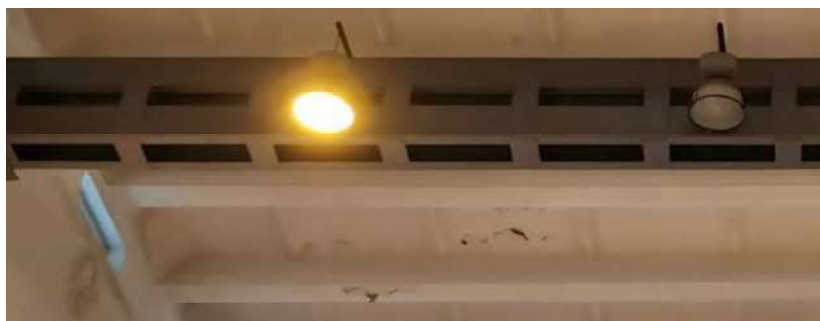
14 pav. Atsilupę dažai nuo denginio plokščių apačios
