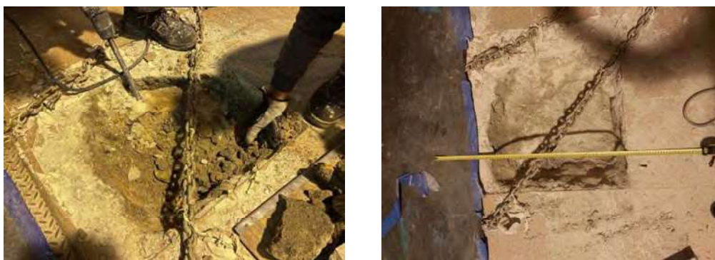
18 pav. Smėlbetonio pasluoksnių ir keraminių plytelių dangų pašalinimas nuo perdangos
