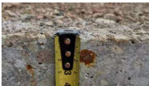
21 pav. Armatūros strypai išlindę į betono paviršių ir veikiami korozijos
