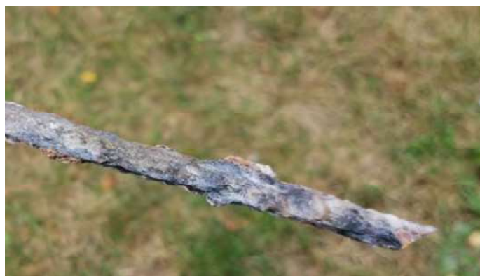
25 pav. Korozijos paveikti gelžbetonio perdangos armatūros strypai
