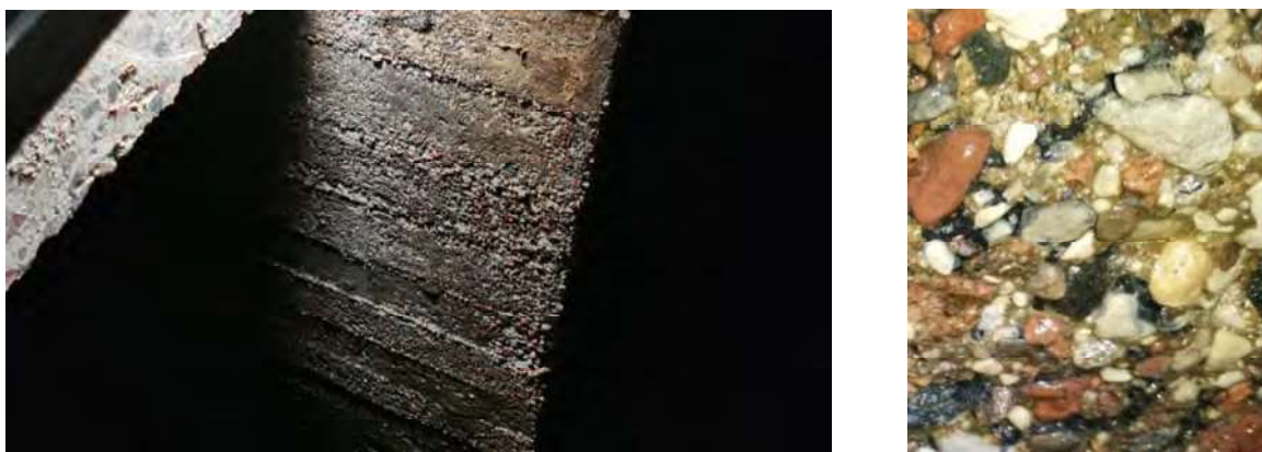
29 pav. Monolitinio gelžbetonio pertvaros šoninių paviršių nelygumai: nuo klojinių lentų; nuo paviršiaus išplovimo, erozijos
