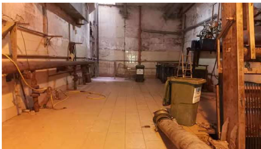
16 pav. Drėgmės žymės ir atsilupę dažai nuo sienų paviršių
